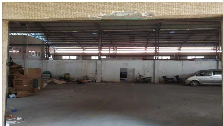
②项目西面——其它厂房
