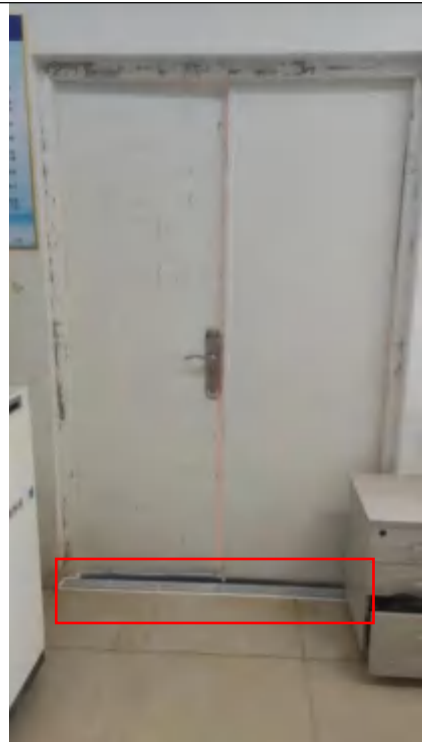
监测站房围堰
